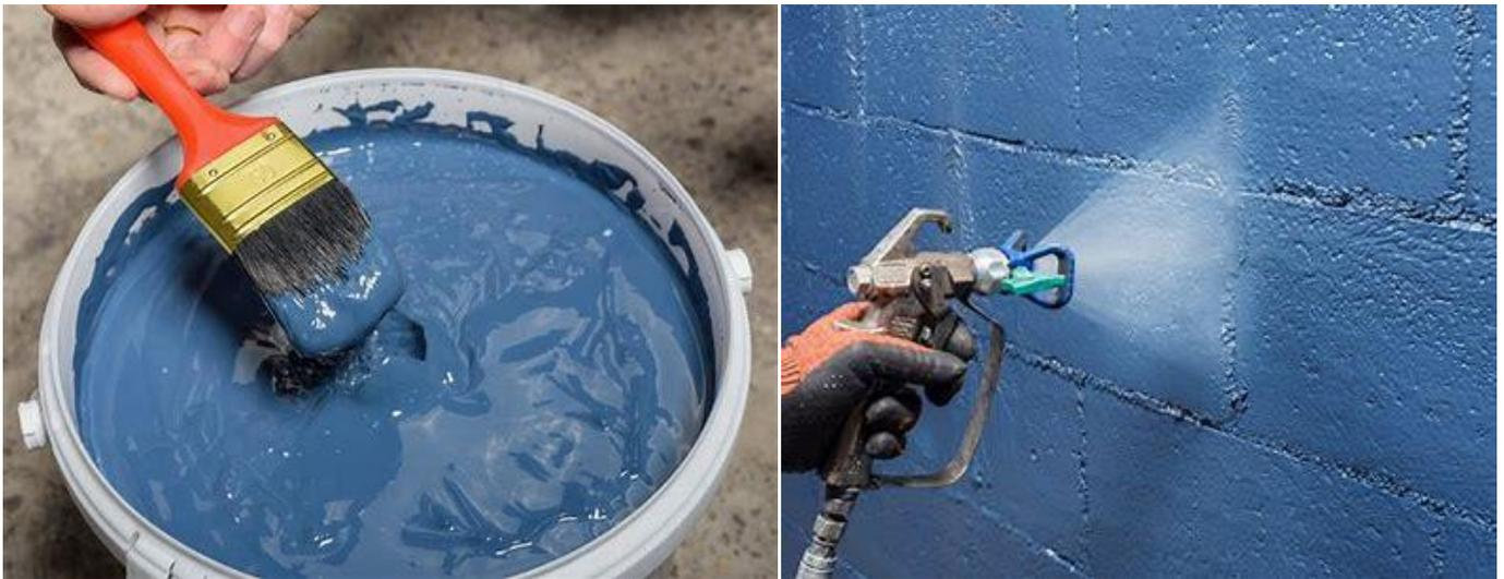
Avant ou après la pulvérisation, les trous et les fissures plus importants peuvent être badigeonnés à l'aide d'une brosse et de pro clima AEROSANA VISCONN FIBRE, le même produit, mais renforcé avec des fibres pour obstruer les interstices plus importants. La fonction principale de ces produits est donc d'améliorer considérablement l'étanchéité à l'air des voûtes.
