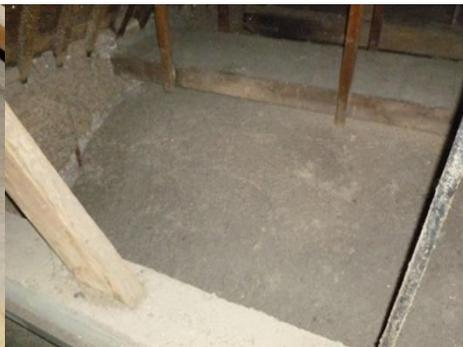
*Photo de droit : Petite déchirure dans la couche d'isolation, à peine visible*
