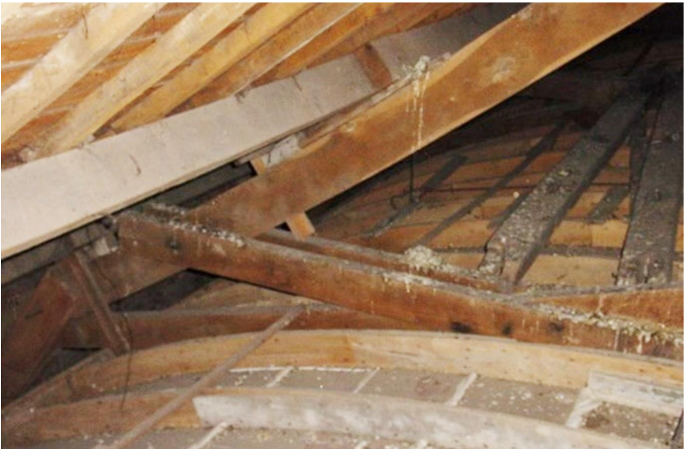
Gewelven vóór het aanbrengen van de isolatie en voorafgaande reiniging.
