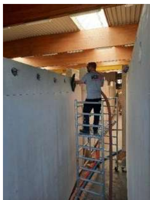
Figuur 7: Verticaal inblazen met de slang, in productie of op de werf.
