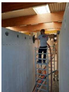
Illustration 7 : Insufflation verticale au tuyau, en production ou sur chantier.
