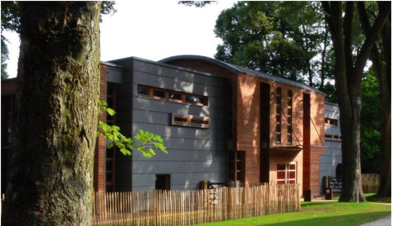
Afbeelding 7: kinderkribbe, plat- en gebogen dak, architect Traits, Genval, 2006
