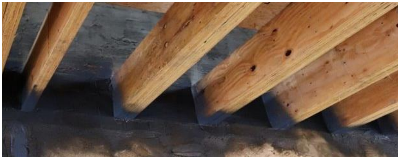
Afbeelding 13: luchtdichting van de zone rond en tussen de roosteringsbalken met pro clima AEROSANA VISCONN (FIBRE).
