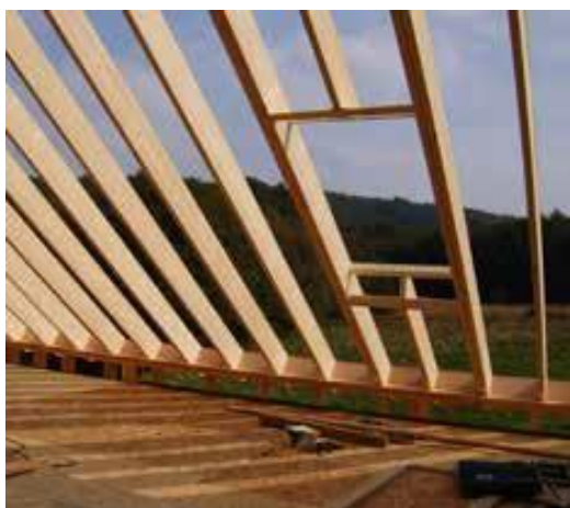
Afb. 18 Gebruik van een mal voor de maatvoering van de ravelconstructie voor een dakraam.
