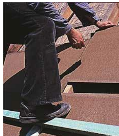
Afb. 8 Plaatsing van de platen.
