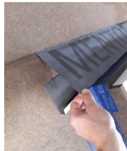
Afb. 13 Voorbeeld van een detail boven een dakraam
