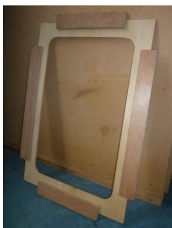
Afb. 18 Gebruik van een mal voor de maatvoering van de ravelconstructie voor een dakraam.
