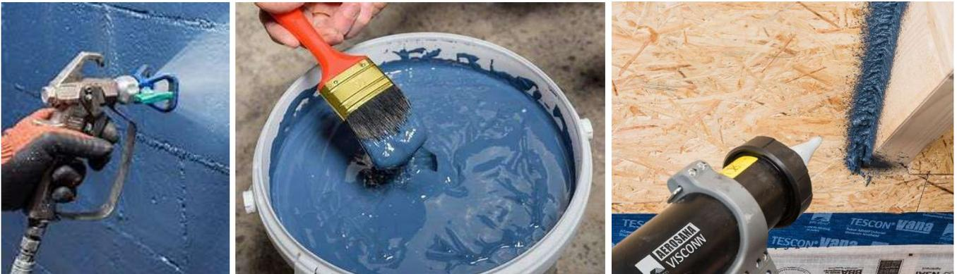
Avant ou après la pulvérisation, les trous et les fissures plus importants peuvent être étanchéifiés avec de pro clima AEROSANA VISCONN FIBRE, le même produit, mais renforcé avec des fibres pour obstruer les interstices plus importants, et ceci à l'aide d'une brosse ou avec le pistolet AEROFIXX, branché à un compresseur. La fonction principale de ces produits est donc d'améliorer considérablement l'étanchéité à l'air des voûtes.
