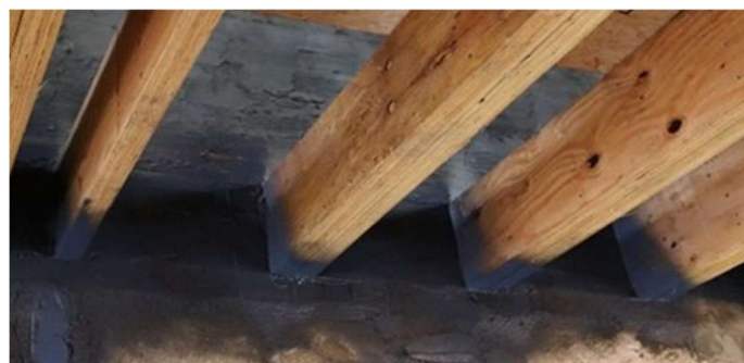
Fig. 11 : Traitement des appuis de poutre avec un badigeon étanche à l'air
