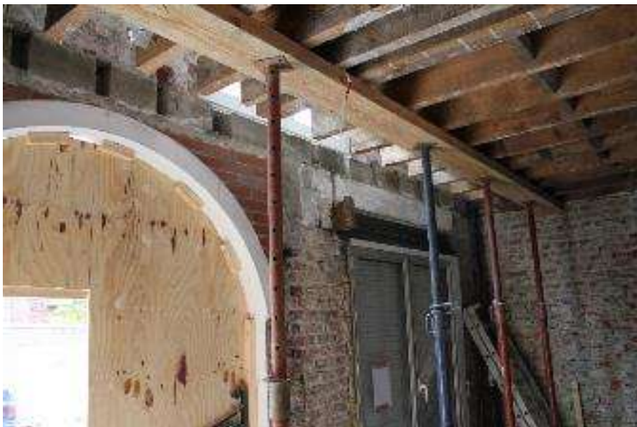
Fig. 13 : Des étais sont placés avant de sectionner les gîtes.
