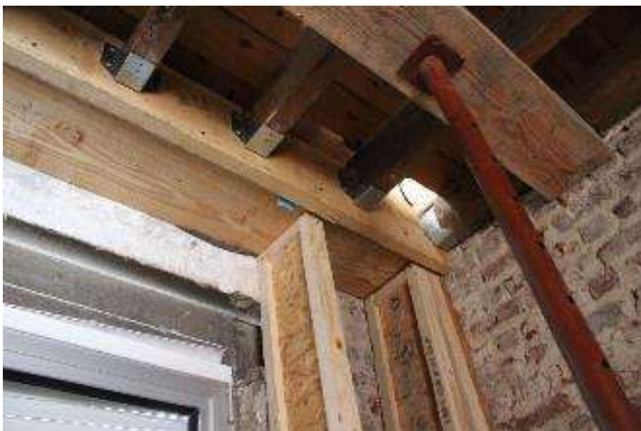
Fig. 14 : les gîtes existantes sont fixées à la nouvelle poutre au moyen de sabots métalliques.
