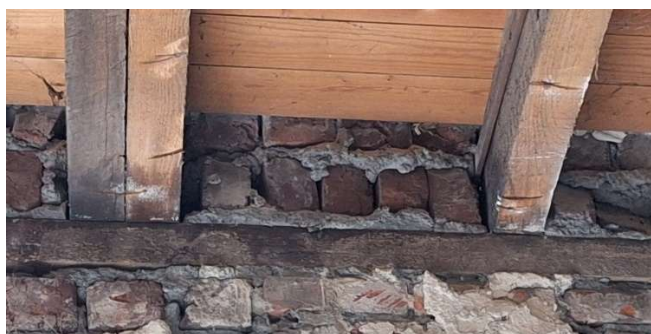
Fig. 11 : État de la maçonnerie entre les appuis des poutres
