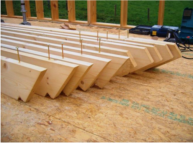
Les chevrons sont préparés et prêt à être posés. Les vis sont déjà engagées.
