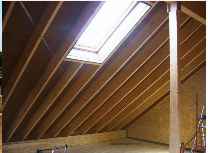
Charpente avec feuillard de contreventement, sous-toiture et fenêtre de toiture.
