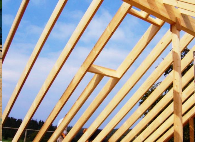
La structure de charpente pourvue d'un chevêtre pour fenêtre de toit
