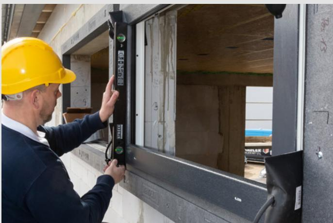
2. Pour le vissage du chambranle dans le profilé blaugelb **Triotherm<sup>+</sup>**, il faut respecter impérativement les indications/écart de fixation figurant dans l'**Annexe III**. Pour la fixation directe des éléments de fenêtre dans le profilé blaugelb **Triotherm<sup>+</sup>**, utilisez **exclusivement** les vis de fixation de cadre blaugelb FK/ZK-T30 7,5 mm homologuées. Ne prépercez pas les profilés blaugelb **Triotherm<sup>+</sup>**.
