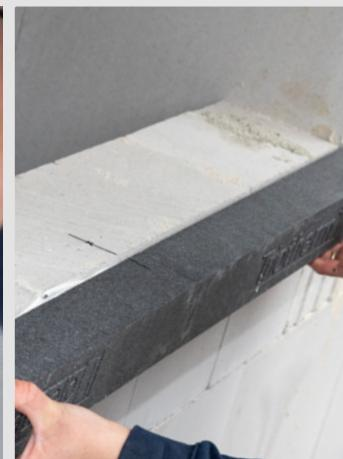
2. Pressez avec force le profilé blaugelb **Triotherm<sup>+</sup>** préparé sur le matériau d'ancrage en tenant compte de la position marquée au préalable. Il est possible de bien presser le profilé avec une massette dotée d'un embout en caoutchouc.
