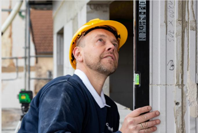
La planéité, la verticalité et l'horizontalité des surfaces du matériau d'ancrage doivent être contrôlées. Il faut respecter les tolérances concernant les entraxes et la maçonnerie.
