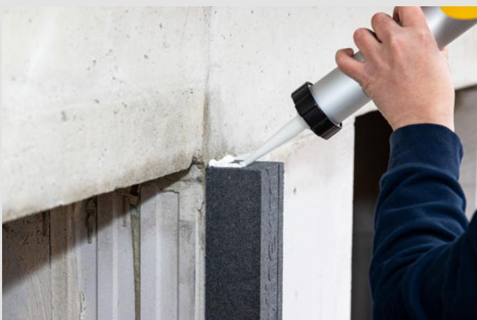
6. Positionnez le profilé blaugelb **Triotherm<sup>+</sup>** supérieur et pressez-le fortement sur le matériau d'ancrage ainsi que sur les profils latéraux.
