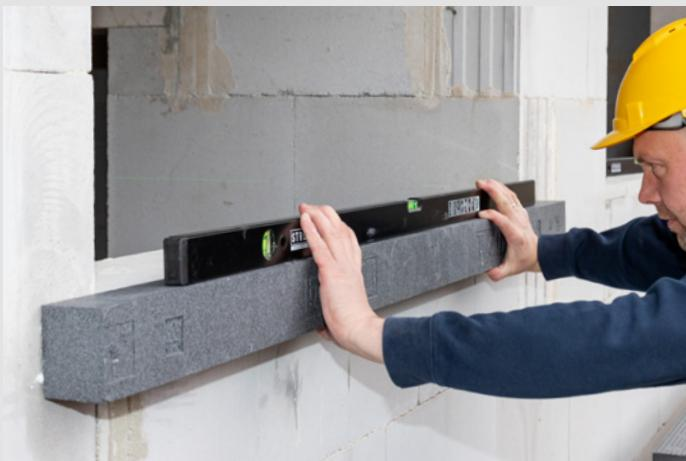
4. Étanchez l'aboutement entre les profils horizontaux et verticaux d'un côté avec du polymère blaugelb Hybrid Polymer Power Fix. Amenez les profils blaugelb **Triotherm<sup>+</sup>** latéraux préparés dans la position correcte et pressez-les fortement sur le matériau d'ancrage.
