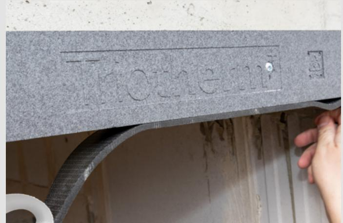
Une fois la bande supérieure fixée, il convient de marquer avec le bloc de montage blaugelb 40x60x10 mm (réf. 0416311) l'écart requis par la bande supérieure pour se dilater.
