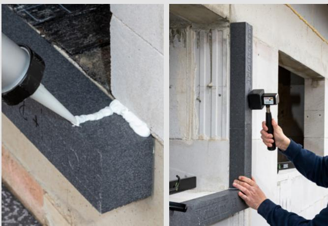
5. Pose du profilé blaugelb **Triotherm<sup>+</sup>** supérieur. Pour cela, étanchez les aboutements des profils latéraux avec du polymère blaugelb Hybrid Polymer Power Fix.
