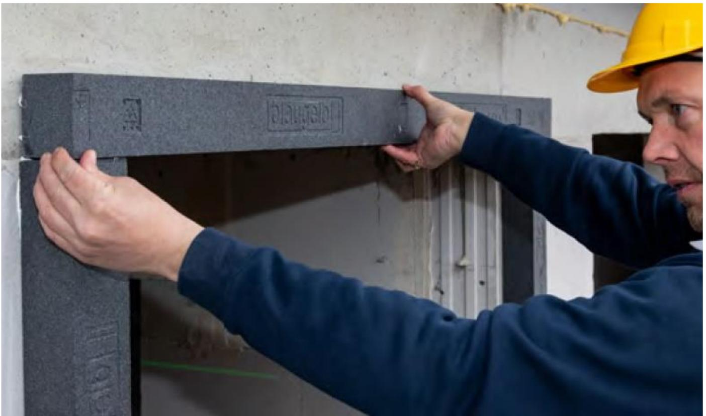
Triothersm<sup>+</sup> permet également une installation **anti-effraction** de la menuiserie (RC 2 et RC 3 selon EN 1627 à EN 1630) et une **protection anti-chute** selon la directive ETB. Enfin, Triothersm<sup>+</sup> constitue une alternative améliorée aux systèmes d'installation basés sur les déchets de PU comprimé.
