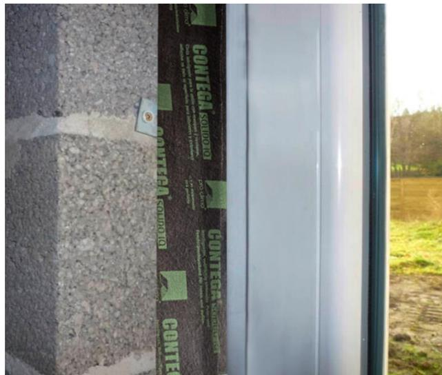
pro clima CONTEGA SOLIDO IQ est un ruban de raccord (pour fenêtre) intelligent, **enduisable**, adhésif sur toute la surface, **pour l'intérieur et l'extérieur**. En raison de la valeur  $\mu$  **hygrovariable**, le ruban de raccord peut être appliqué aussi bien sur la face chaude que sur la face froide de la menuiserie.
