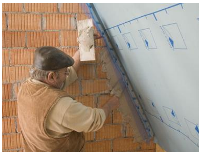
Luchtdicht aansluiten van een damprem op een te bepleisteren muur.
